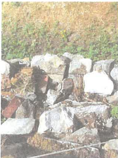
Mur sett ovenfra og ned.
