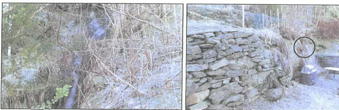
Figur 3. Bilde av venstre viser bekken mellom Tyssevegen 222, 230 og 224, på oppsida av gangvegen. Bekken renn på fjell. Bilde til høgre viser muren, eller ein stabla røys, på nedsida av gangvegen mellom 222 og 230 og viser bekken på nedsida av gangvegen (svart sirkel), moglegvis i fjell? (vart ikkje sjekka på synfaringa).
