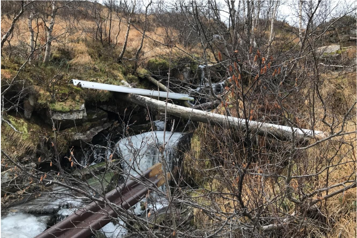
Figur 10: Restar av brukonstruksjonar ligg spreidd i vassvegen ved bekken som drenerer gjennom planområdet langs nordleg plangrense.
