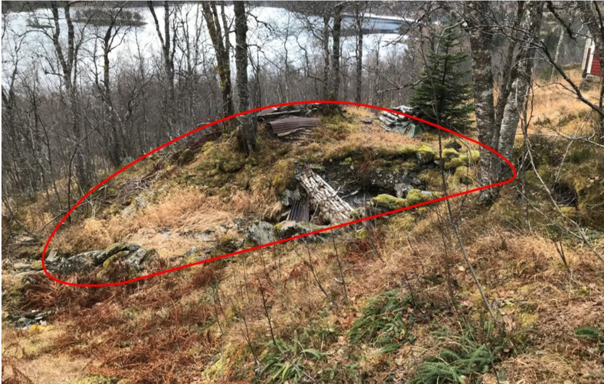
Figur 11: Lausmasse-opsamling i bekkefaret for den store bekken omlag midt i tiltaksområdet (Omrissa med raudt).
