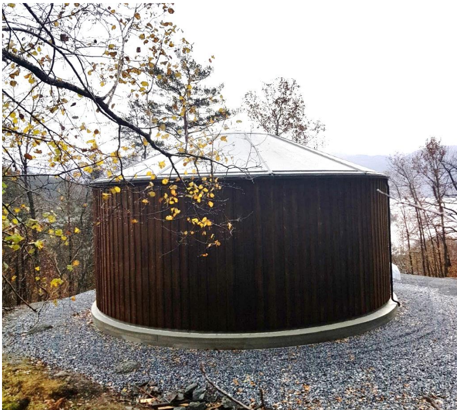
Ferdig høgdebasseng i Nordbygda.
