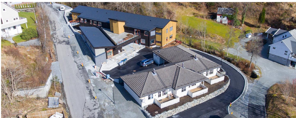
Skottabakken bufelleskap, nybygg og eksisterande bustader.
