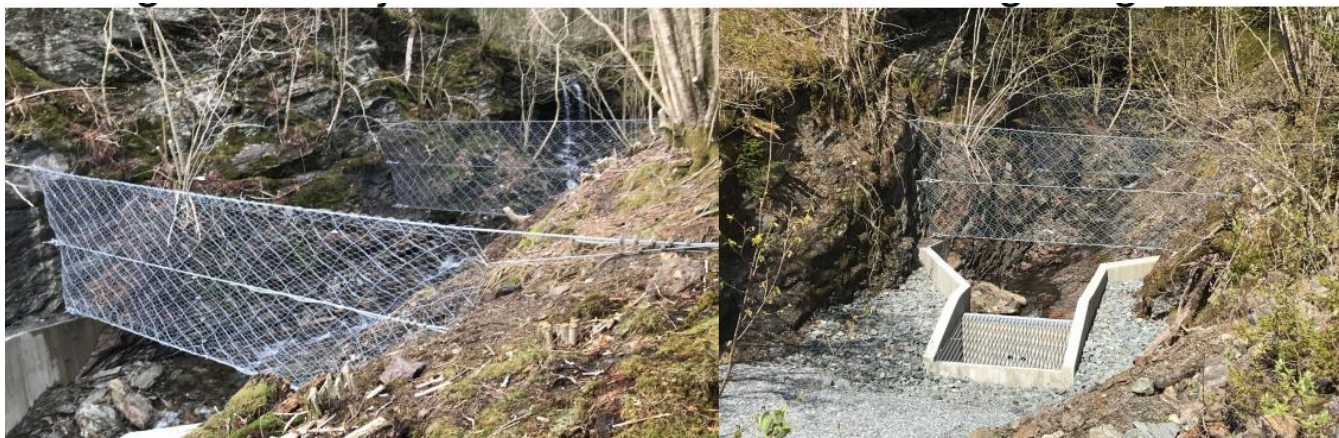
Ras og flaumsikring Nordbygda/Skottabakken.
