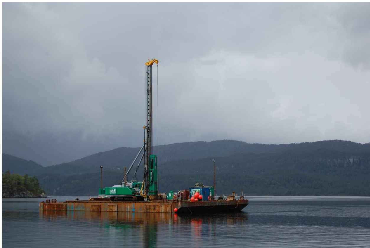
Det må store maskiner til for å fornya Ytre Tysse
